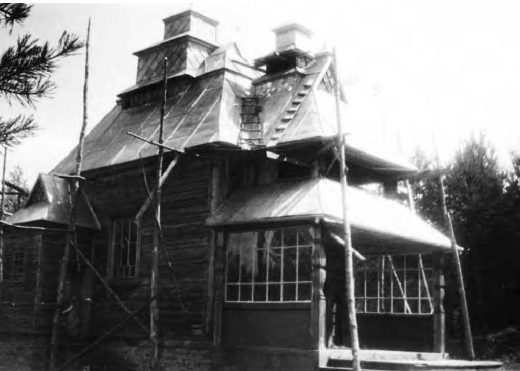
Remont kaplicy, lata 60. XX w.
